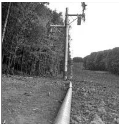
A FELVONÓ ÉS A HÓÁGYÚHOZ A VÍZVEZETÉK
